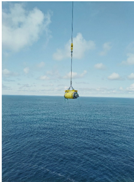
RB-Kompressoreinschub während der Verladung auf Equinors Troll-A-Plattform in der norwegischen Nordsee © Everllence
